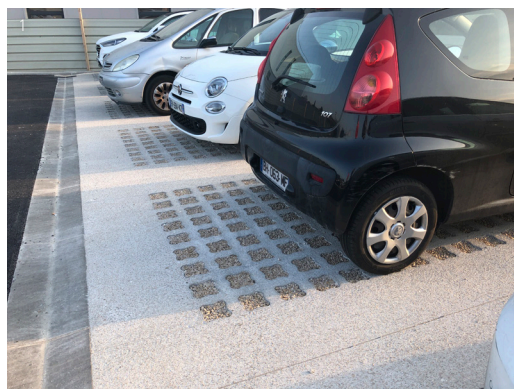
[1] Dalles alvéolées en béton coulé en place et remplies de granulats à Marseille [© Via Sols] [2] Ecoulements pluviaux guidés vers un sol poreux à Aubagne [© Agam]
